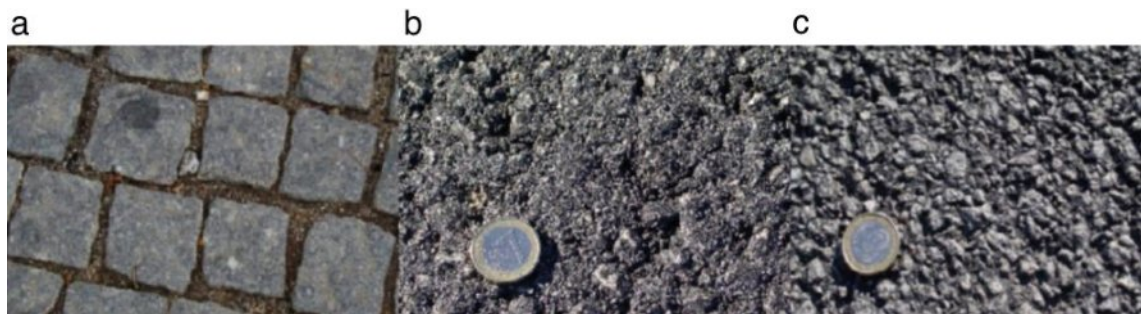
Figura 2: Aspeto da superfície: (a) cubos de granito, (b) mistura betuminosa densa, (c) mistura betuminosa com betume modificado com borracha
